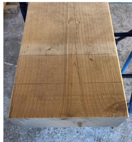
Si nécessaire coupez le bout de la poutre parallèlement à l'arase afin d'avoir la longueur d'assemblage voulue entre l'arase tracée précédemment et le bout de la poutre.
